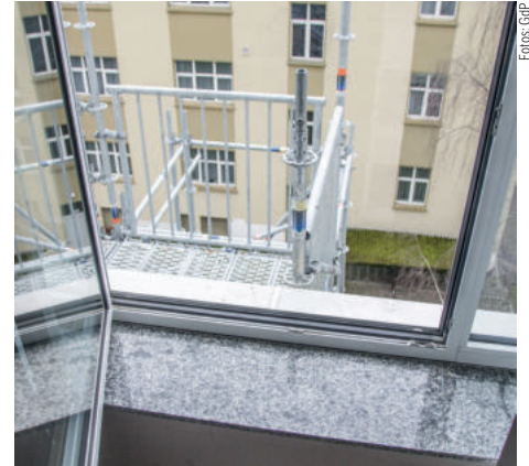
... sollten dabei jedoch nicht zu weit rechts treten, da die Treppe nur das halbe Fenster abdeckt!
