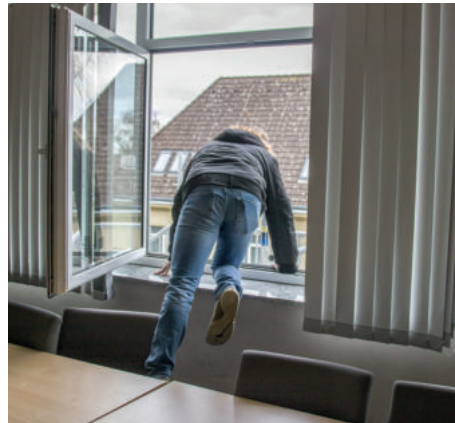
Da es keine Tür gibt, müssen Personen durch ein Fenster steigen, um auf die Treppe zu gelangen, ...
