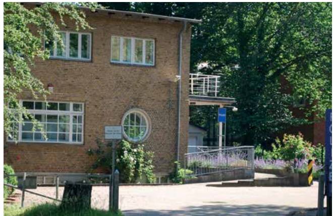
Das Dienstgebäude der Polizeistation Neumünster Mitte
