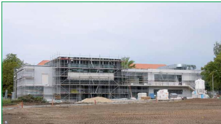
In den Jahren 2009/2010 wurde die FH Polizei mit über 20.000.000 € aus den Mitteln des Konjunkturpakets II saniert. Allerdings nur für eine Kapazität von ca. 300 Studenten/Auszubildenden. Foto: Jens Hüttich
