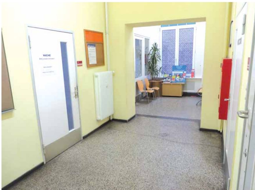
Für jedermann frei zugänglicher Flur und gleichzeitig ungesicherter Wartebereich, leider nicht rollstuhlgerecht.
