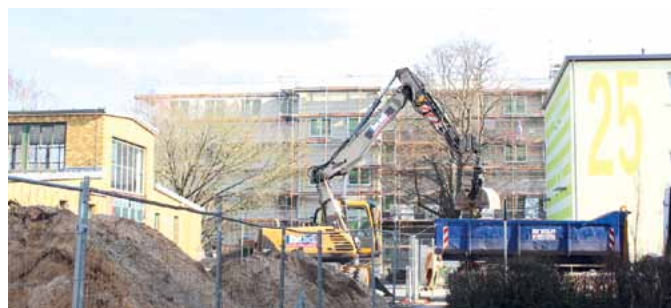
Umbaumaßnahmen sind nicht nur äußerlich notwendig
