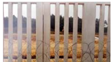
Betonzaun mit S-Draht ©archiv gdp wi
